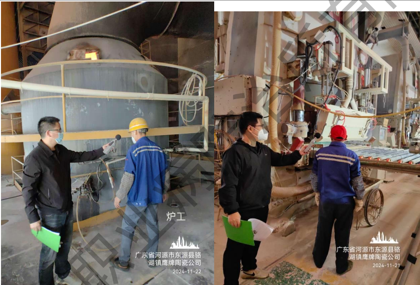
现场定点噪声测量
