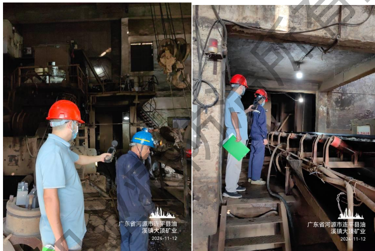
现场定点噪声测量
